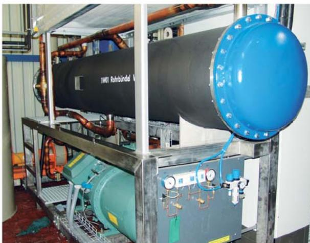
Wärmepumpenverdampfer  $\text{H}_2\text{SO}_4 + \text{H}_3\text{PO}_4 + \text{Al}$
