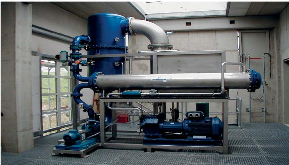
Wärmepumpenverdampfer; ATEX  $\text{H}_3\text{PO}_4$ ,  $\text{H}_2\text{O}$  + Ethanol
