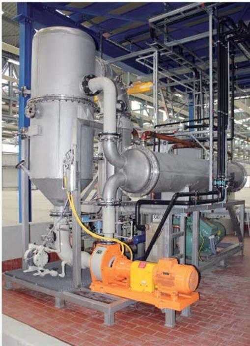
Wärmepumpenverdampfer  $\text{H}_2\text{SO}_4 + \text{H}_3\text{PO}_4$
