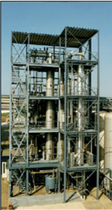
Extraction liquide liquide avec régénération du solvant
