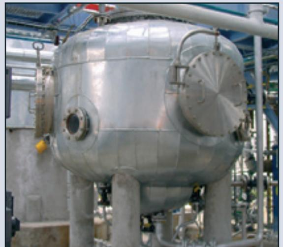
Mélangeur décanneur à deux étages type MSV 250-3
