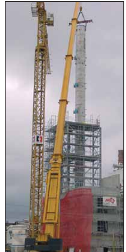
Aufbau einer Rektifizierkolonne
